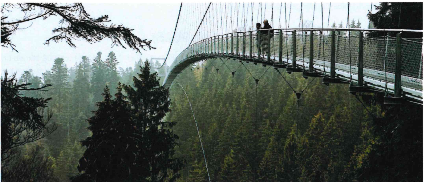
WILDLINE - Die Hängebrücke in Bad Wildbad im Schwarzwald
