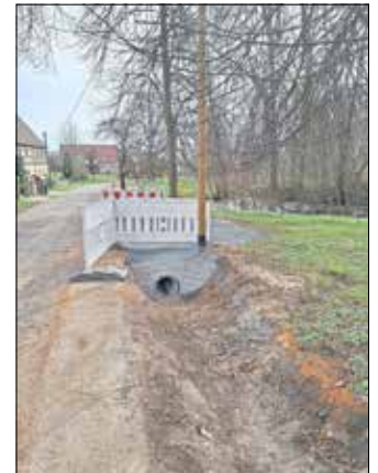
Entwässerung Oberdorf Hohburkersdorf
